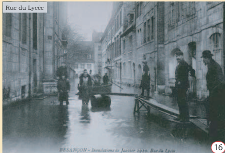
Rue du Lycée
